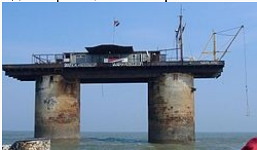
Силенд после пожара
