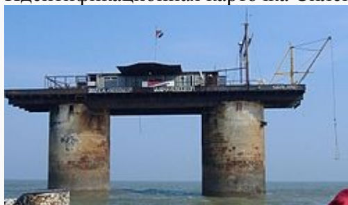
Силенд после пожара
